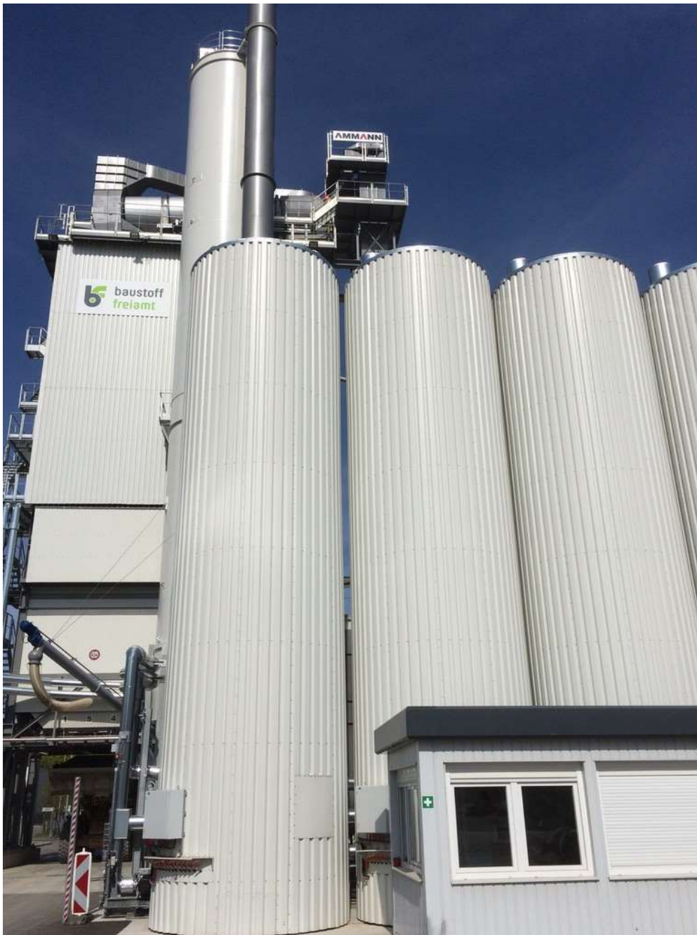
Abbildung 7: Ansicht der Bitumensilos und des 37m hohen Mischturms
