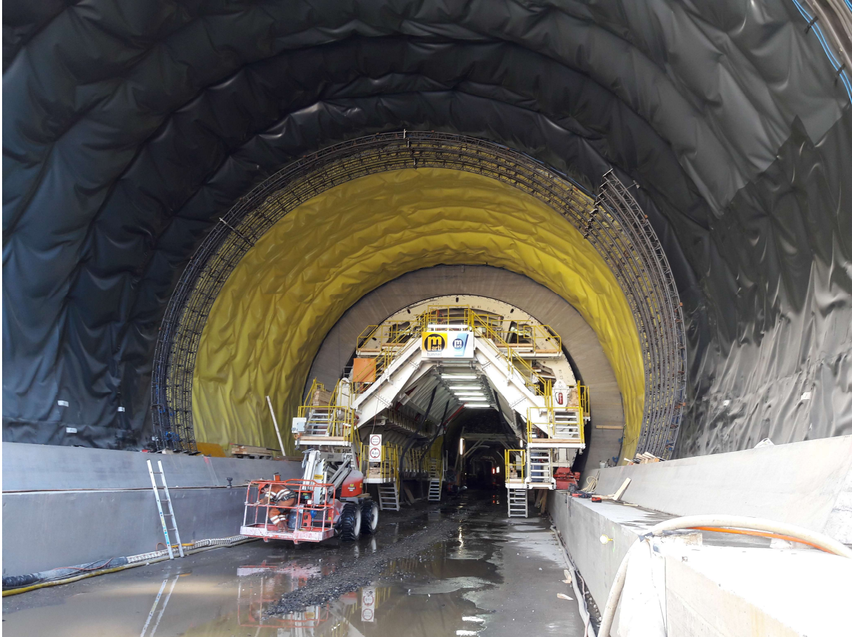
Abbildung 2: Tunnelinnenschale des Bergmännischen Tunnels im Rohrschirmverfahren
