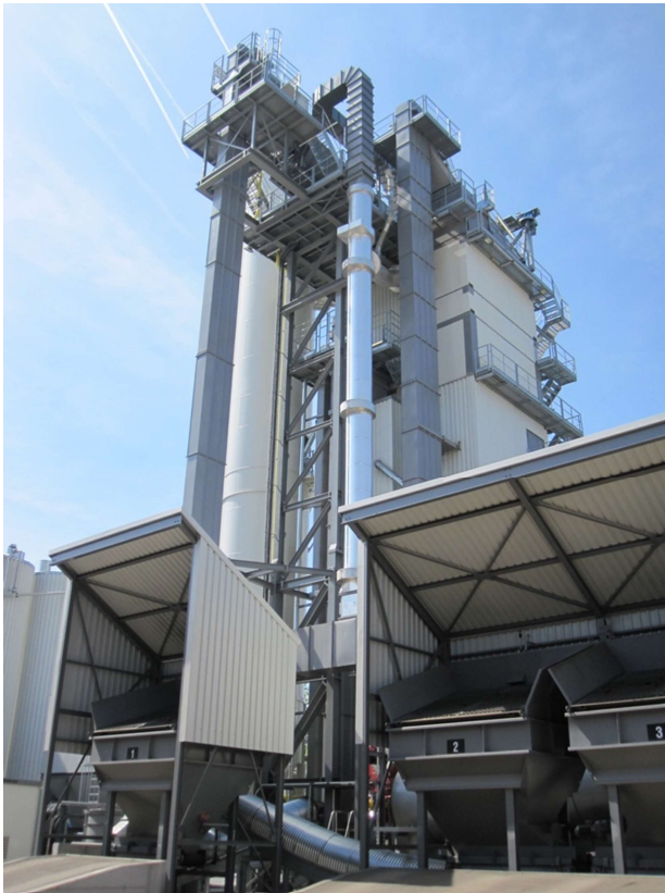
Abbildung 8: Süd-Ansicht des Mischturmes mit Vordosierungsbunkern
