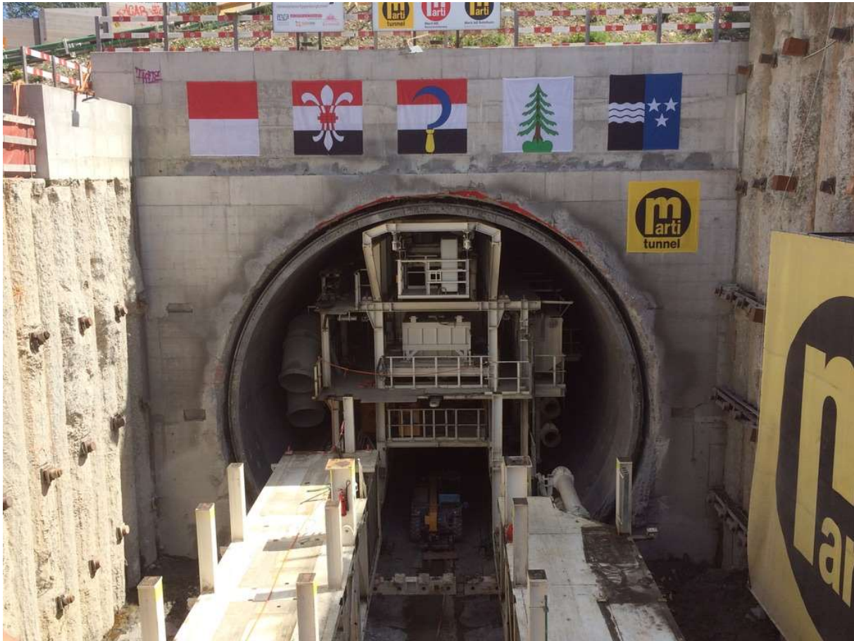
Abbildung 6: Nachläufer der Tunnelbohrmaschine am Durchbruch in die Endbaugrube
