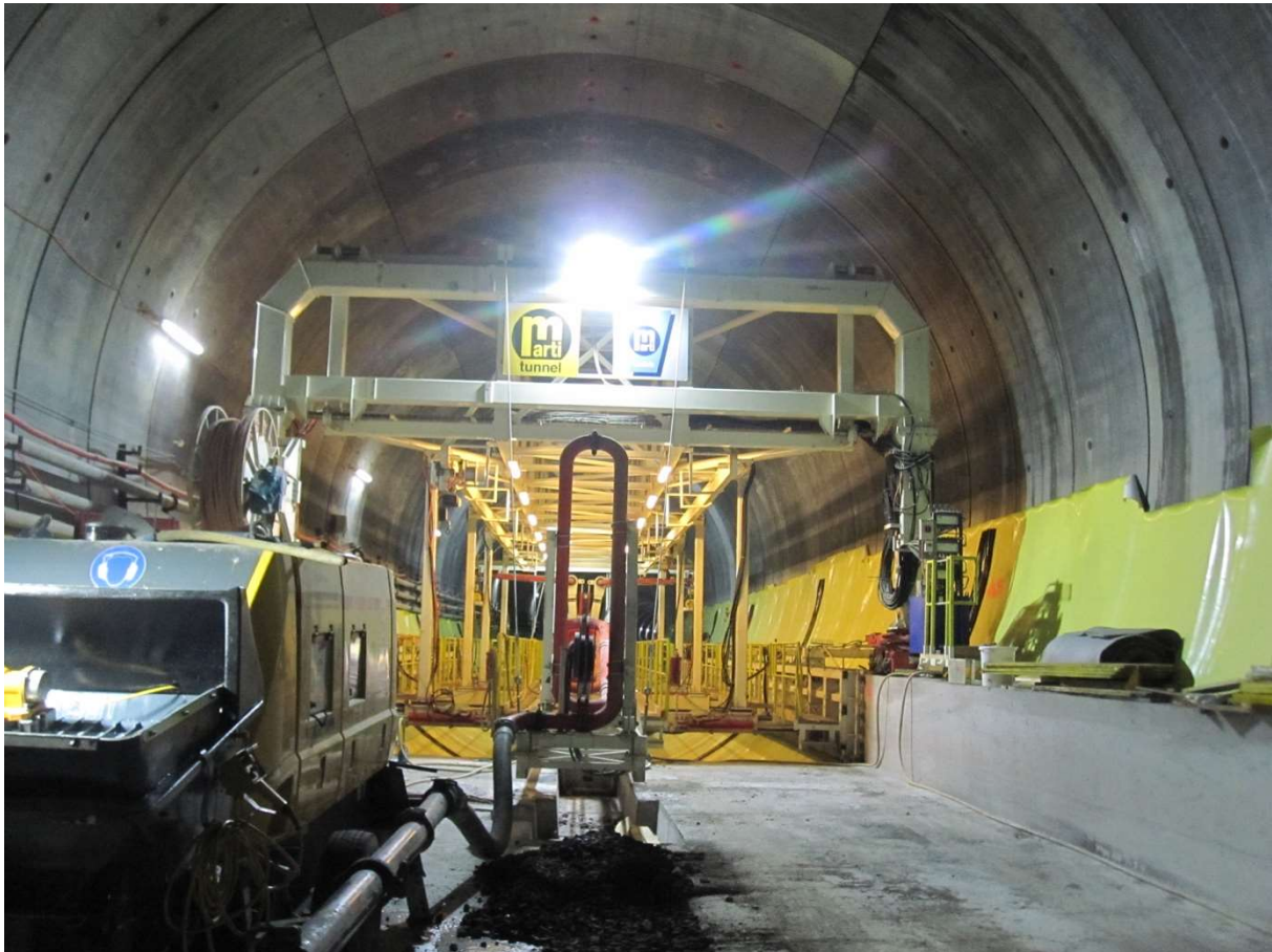
Abbildung 4: Ansicht hinter dem Betonierwagen zum Betonieren der Sohle
