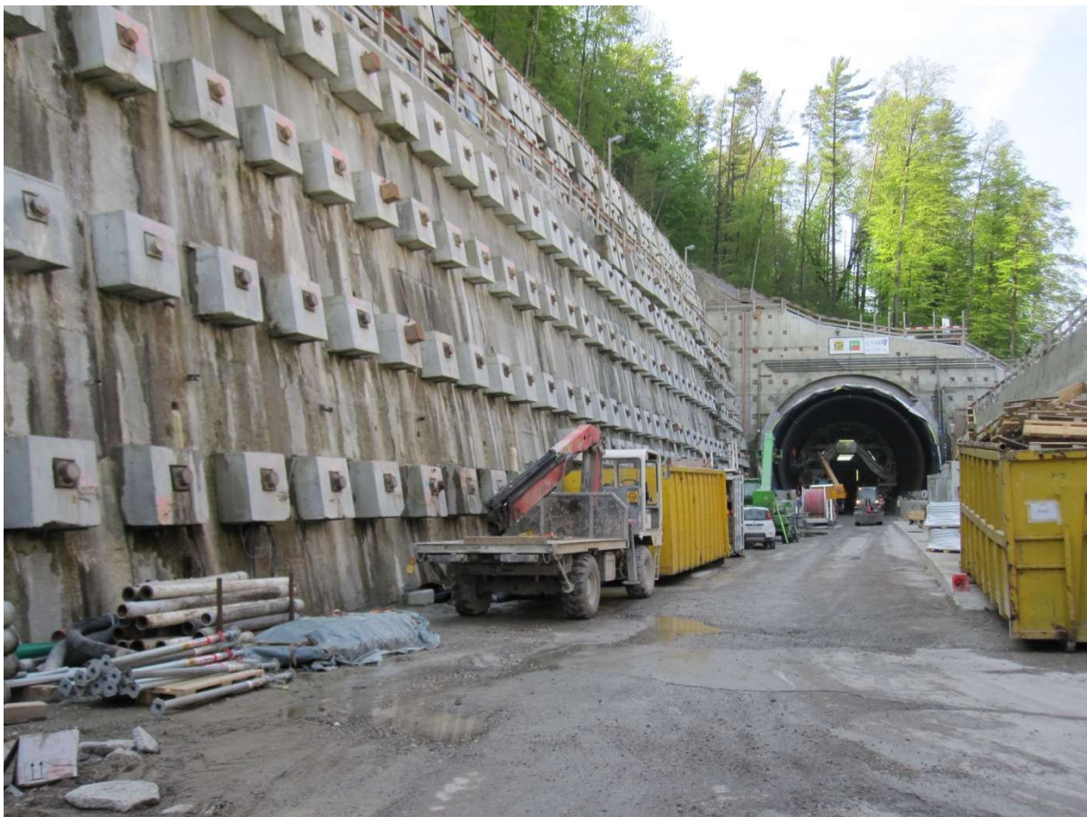
Abbildung 1: Baugrubenverbau mit Spannankern gesichert
