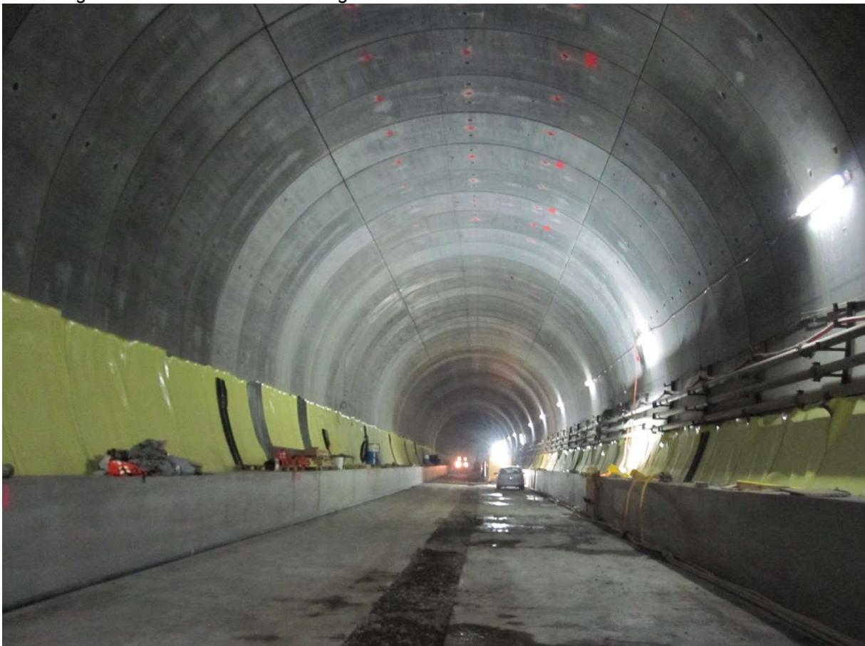
Abbildung 3: Tunnelsohle und Tübbinge im maschinellen Vortrieb
