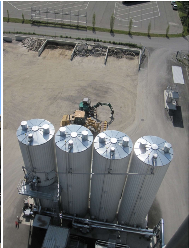
Abbildung 9: Ansicht der Bitumensilos vom Turm
